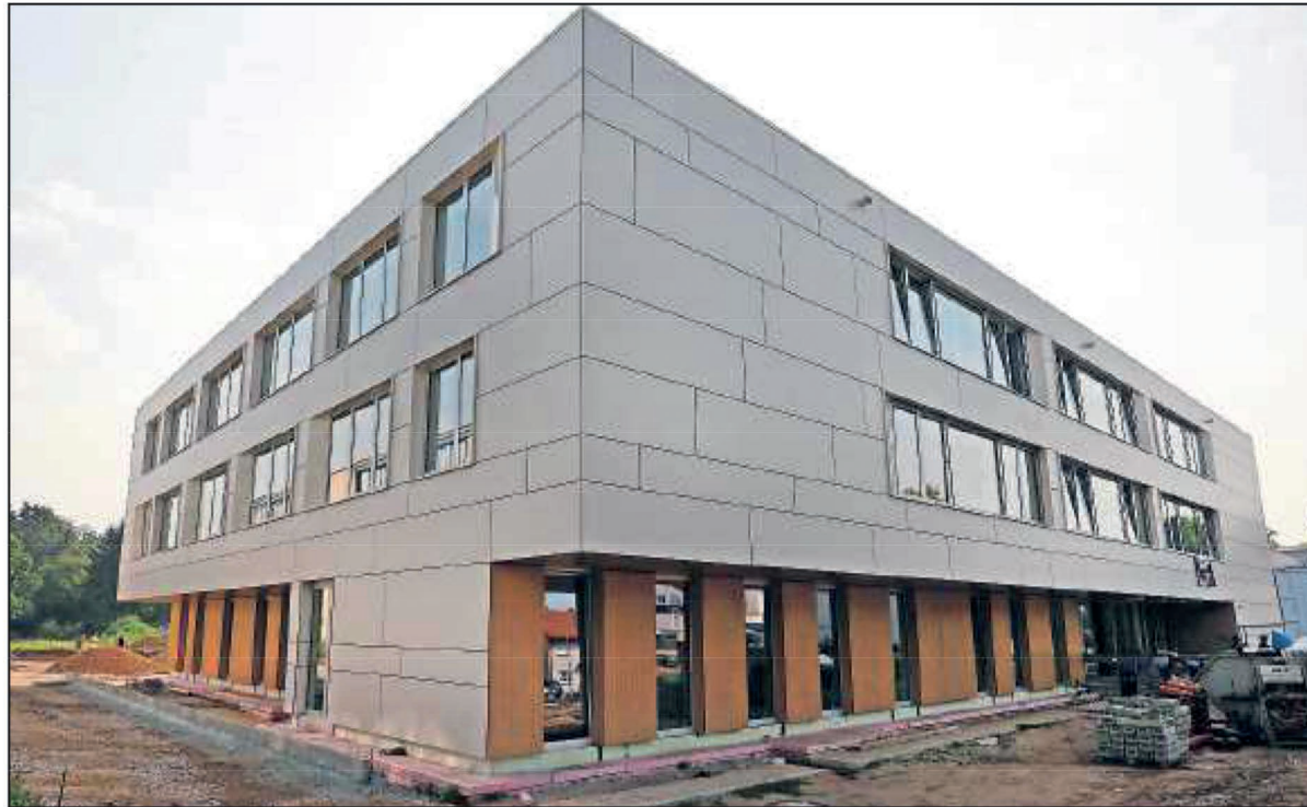
Der Außenbereich ist als nächstes dran: der Schul-Neubau in Rülzheim.
